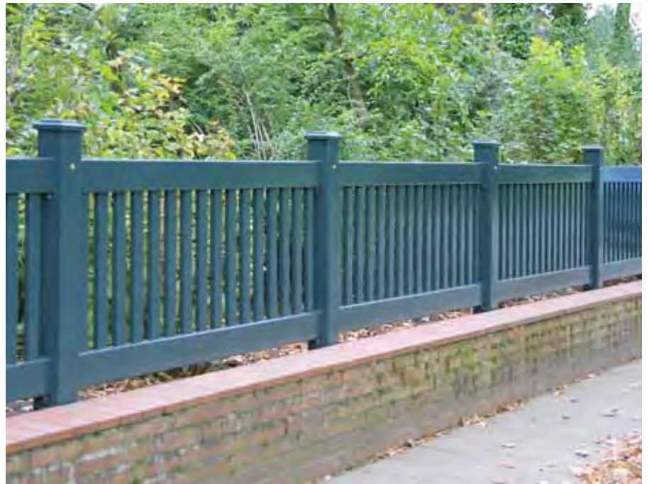
Eine überzeugende Lösung - Zaunelemente passend zum vorhandenen Mauersockel.
