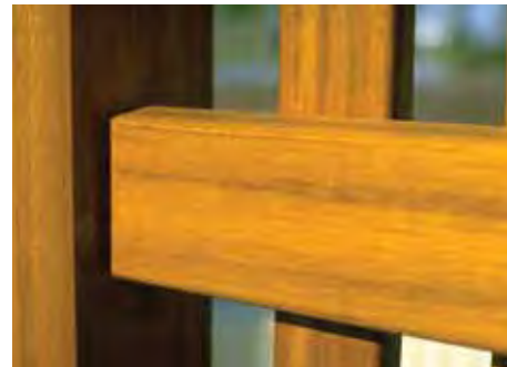
3. Abgeschrägte Querriegel der Zaunelemente
